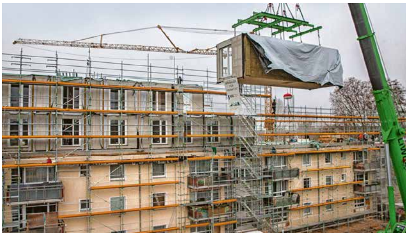
Zwei neue Stockwerke: Dachaufstockung mit vorgefertigten Bauelementen in Frankfurt
