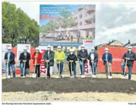
Am Montag fand der Spatenstich statt.
