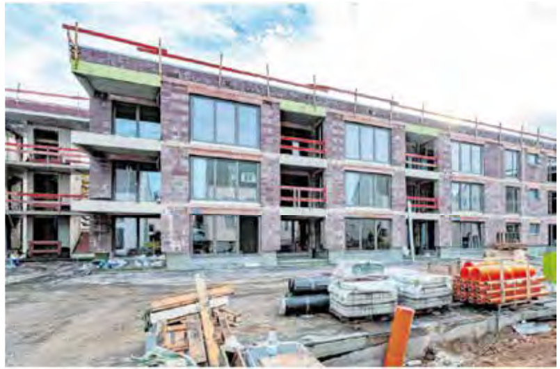
An der Mörikestraße in Bissingen entstehen neue Wohnungen der LBG.
