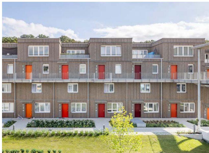
In den sogenannten Stadthäusern befinden sich Maisonette-Wohnungen. Gepflegte Grünflächen erinnern an die gärtnerische Vergangenheit
