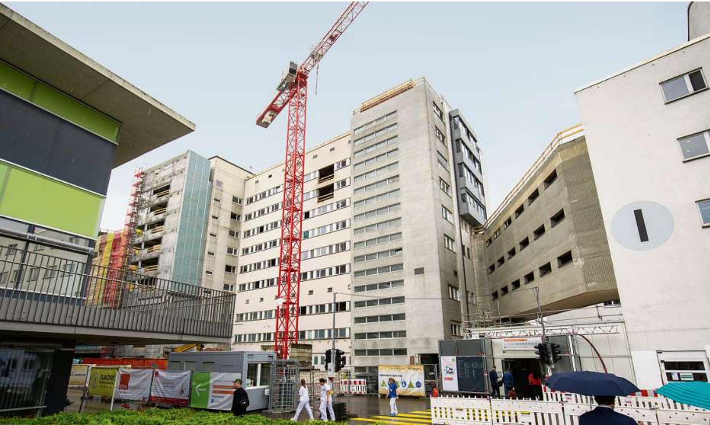
Das Stuttgarter Klinikum ist seit Jahren eine Großbaustelle – und soll es bis 2033 bleiben.
