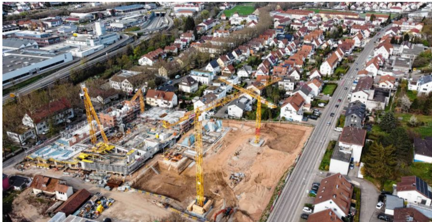
Das „Wohnen in den Fehrlegärten“ nimmt Gestalt an. Die Tiefgarage im Norden ist fertig, die Hochbebauung schreitet von der Schwerzerallee Richtung Goethestraße voran. Foto: Jan-Philipp Strobel
