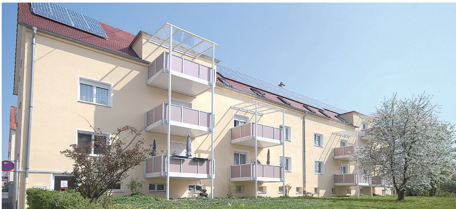
Wurden umfangreich modernisiert: LBG-Wohnungen in der Villeneuvestraße in Kornwestheim.
