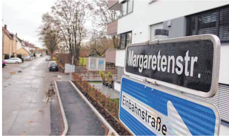
Am östlichen Ende der Margaretenstraße hat die Zeppelin Wohlfahrt vier Häuser hingestellt, die LBG folgt nebenan nach.
