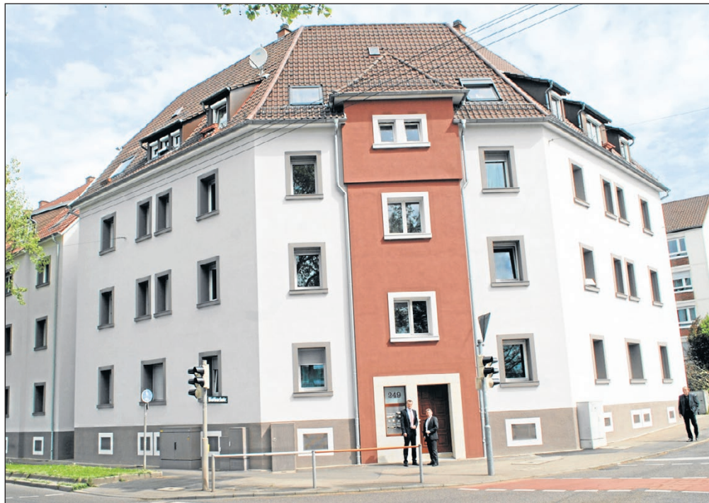
Beispiel für gelungene Modernisierung: Das Gebäude der Landes-Bau-Genossenschaft in der Augsburger Straße 249 erhielt einen Vollwärmeschutz und zeitgemäße Wohneinheiten. Fotos: Kuhn
