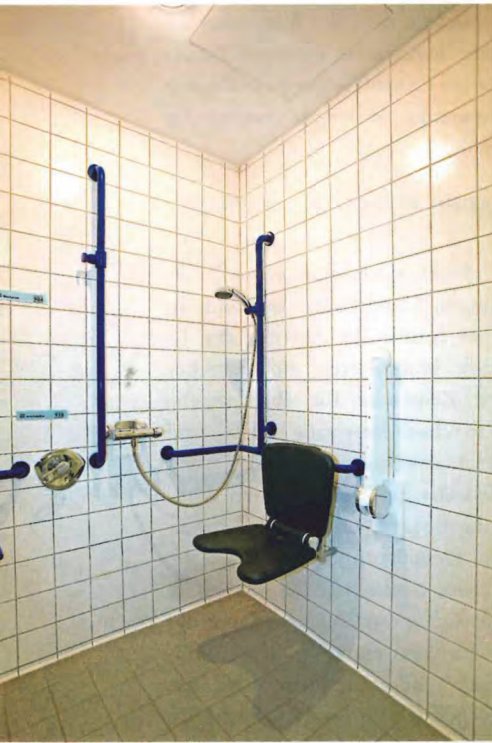
Wichtig für ältere Menschen: Ein behindertengerechtes Bad und große Wohnräume
