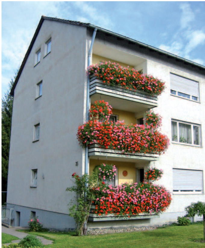
In diesem Reutlinger Wohngebäude der LBG aus den 50er-Jahren wurden die Bäder saniert und mit Stahl/Email-Duschflächen von Bette ausgestattet.
