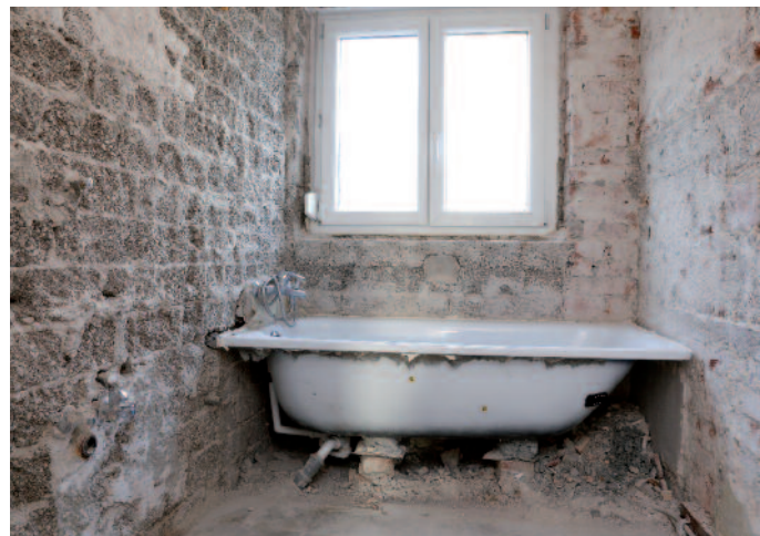
Fünf Bäder wurden entkernt – dabei wurden auch die Badewannen entfernt.
