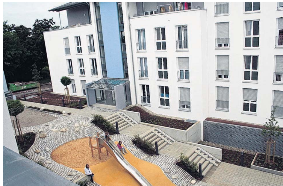
Mehrgenerationenhäuser werden immer beliebter, so wie dieses der Flüwo. Foto: Hemminger
