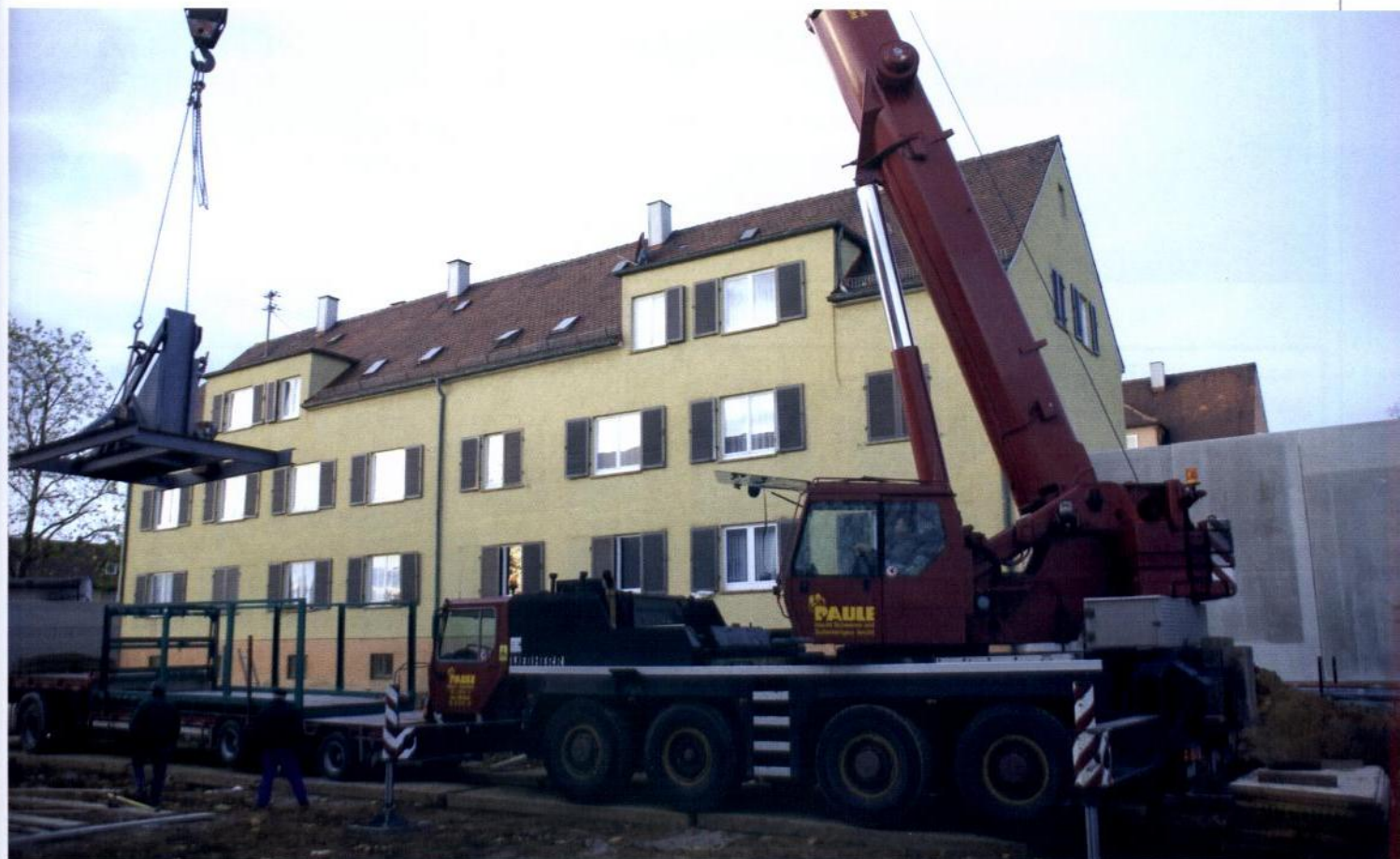
In der Weststadt von Kornwestheim werden im Rahmen des aktuellen Fünf-Jahres-Modernisierungsprogrammes die bestehenden Wohnungen der LBG u.a. mit Pelletsheizung, Wärmedämmung und seniorengerechten Badumbau zukunftsweisend modernisiert
