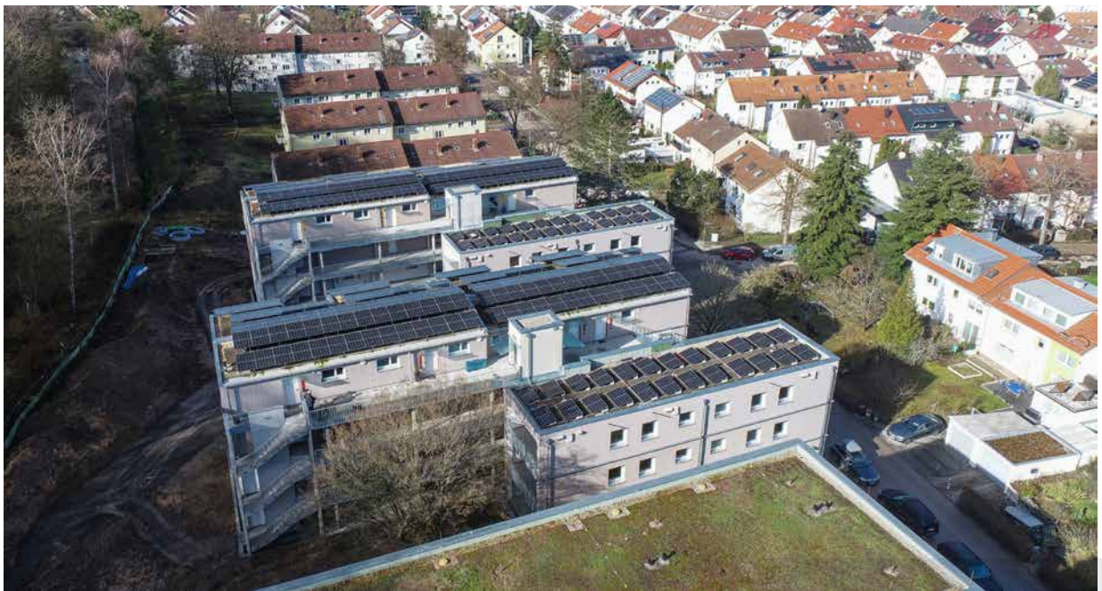
im Vordergrund der fertiggestellte BA2
